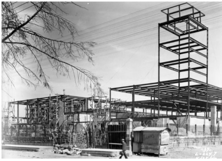
Edificio en construcción para las nuevas oficinas de la Estación Unión en San Luis Potosí, 25 de mayo de 1940. Fondo Ferrocarriles Nacionales de México, Sección Comisión de Avalúo e Inventarios. Secretaría de Cultura, CNPPCF, CEDIF.
