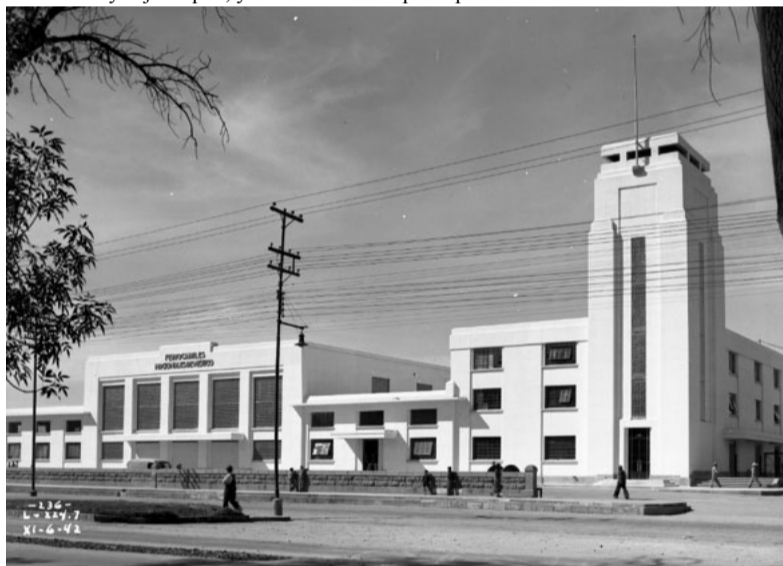
Vista de conjunto de la nueva estación de San Luis Potosí, 6 de noviembre de 1942. Fondo FNM, Sección Comisión de Avalúo e Inventarios. Secretaría de Cultura, CNPPCF, CEDIF.
