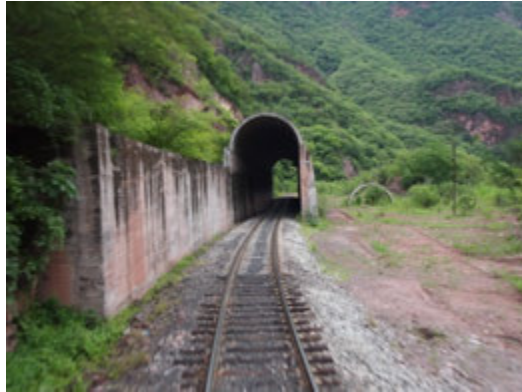
Túnel N°. 73A salida (28-07-2012)
