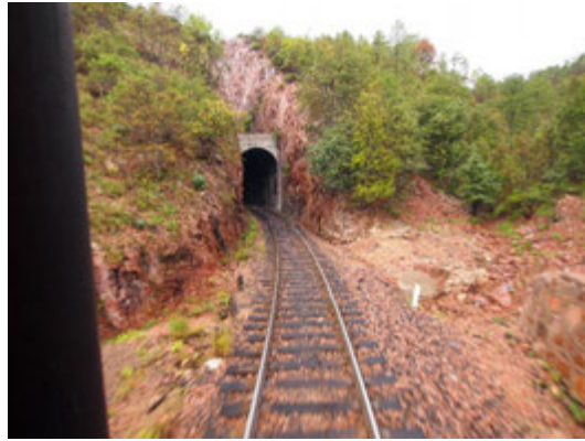
Túnel N°. 4A (30-07-2012)
