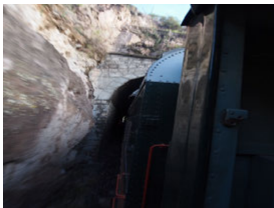
Túnel N°. 1 con portales de mampostería (28-07-2012)
