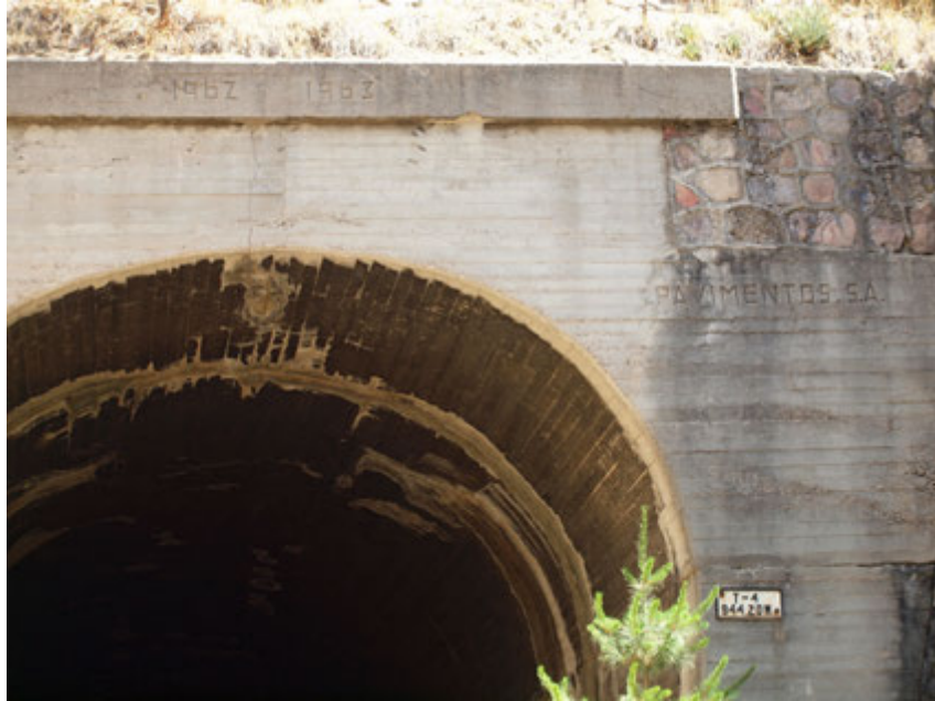
Fecha de construcción del Túnel N° 4, 1962-1963 (29-03-2013)
