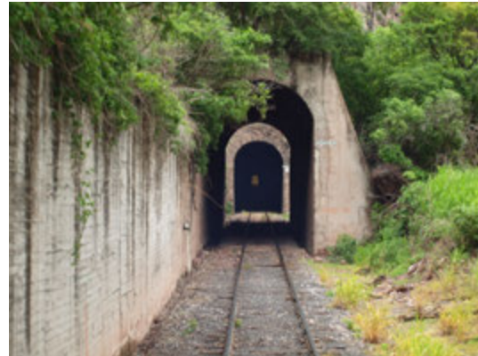
Túnel N°. 42A (28-07-2012)
