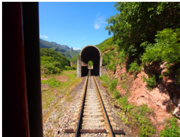
Túnel N°. 73A entrada (30-07-2012)
