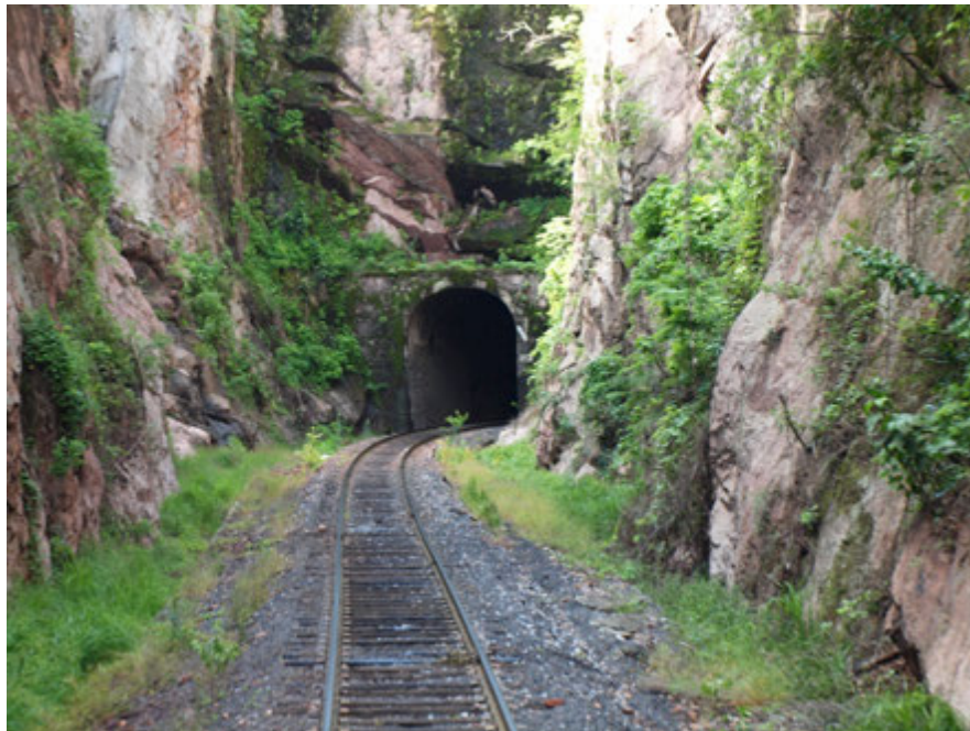
Túnel N°. 86 El Descanso (30-07-2012)
