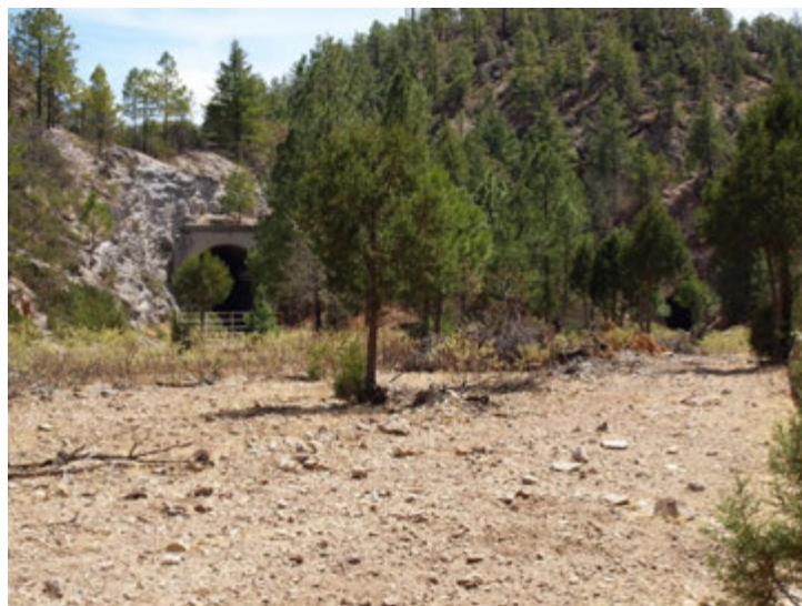
Salidas de los túneles N° 5, a la izquierda, y del N° 4A Cumbre, a la derecha (29-03-2013)
