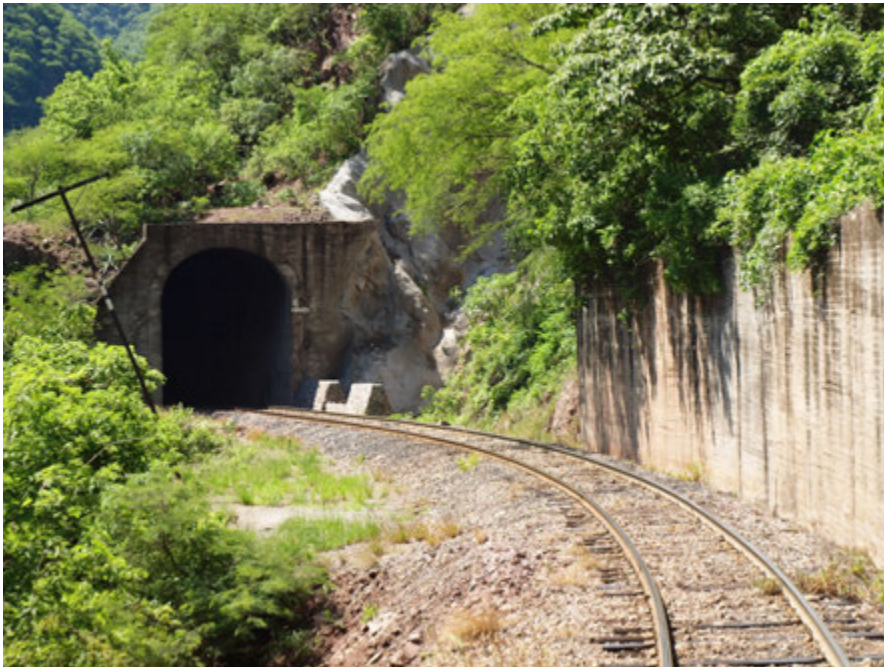
Túnel N°. 59A (30-07-2012)
