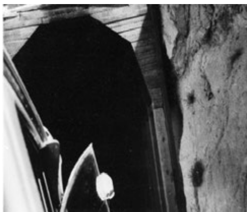
Túnel N°. 1 con portales de madera (04-07-1957) CEDIF.
