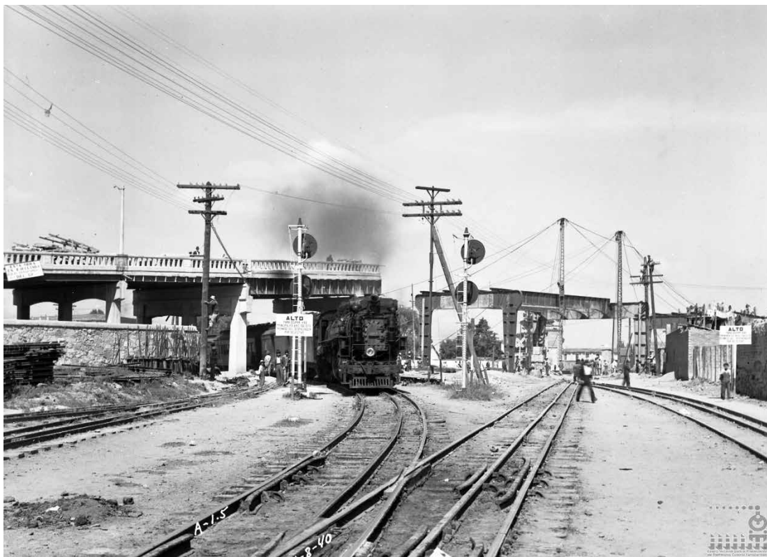
Detalle de las vías del patio de Buenavista, abajo del paso elevado en construcción por el Departamento del Distrito Federal, 8 de noviembre de 1940. Fondo FNM, Sección Comisión de Avalúo e Inventarios. CEDIF, CNPPCF, Secretaría de Cultura.
